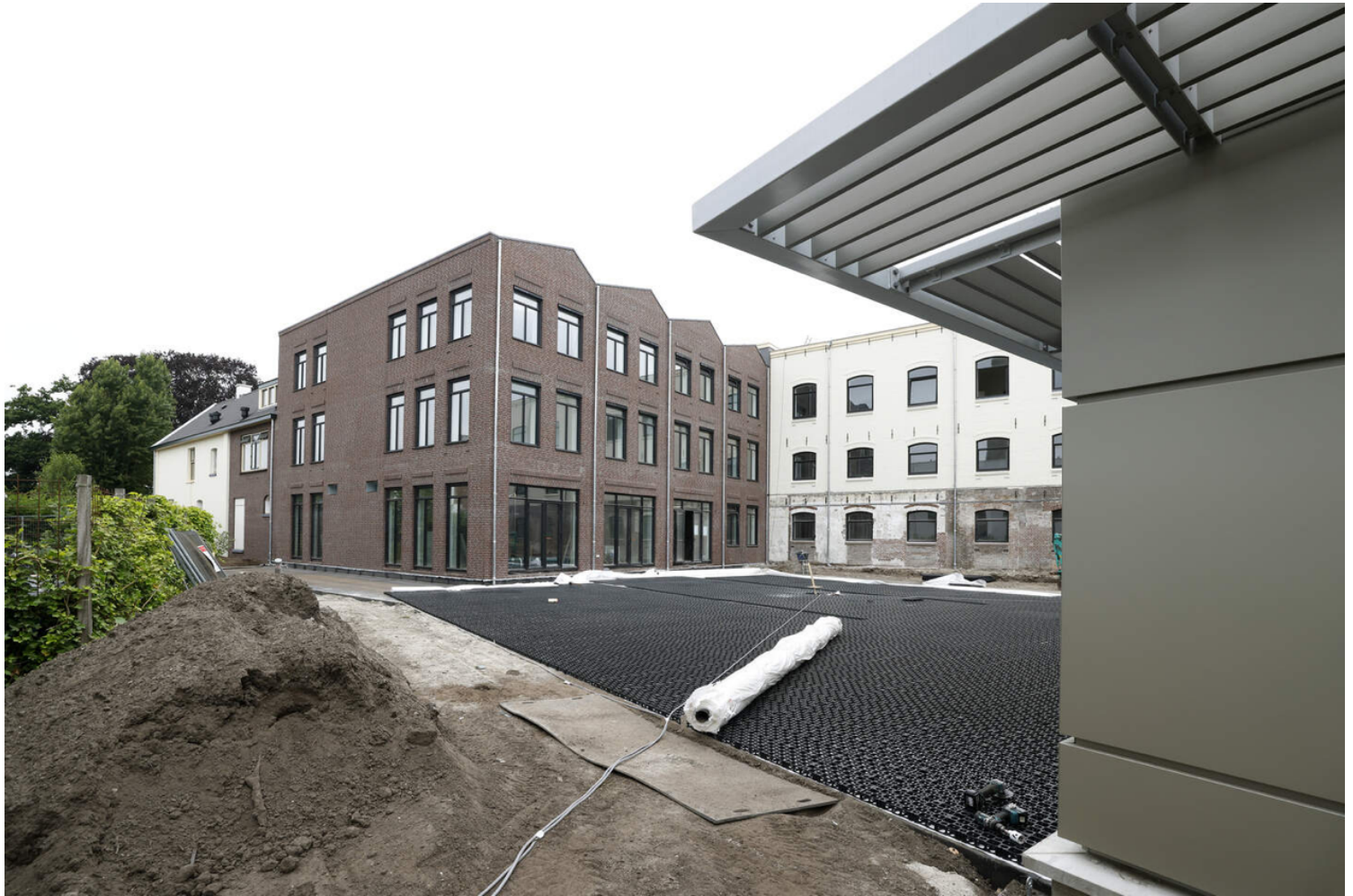
Rond de binnentuin in aanbouw staan de oude Sigarenfabriek en de nieuwbouw. Samen met de Witte Villa vormen ze een miniwijk. © Foto Studio Kastermans/Alexander Marks
